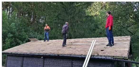
**Entfernen des Altdachs aus Bitumenwellplatten**
