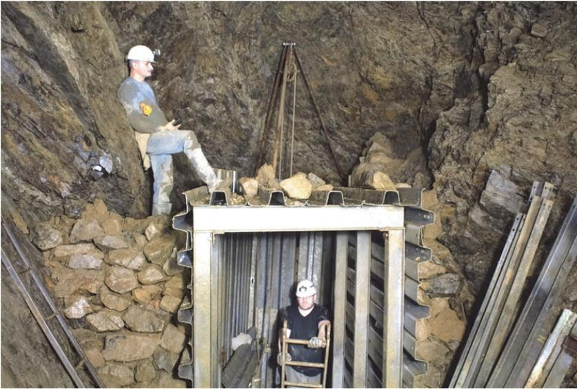
**Abb. 15: Streckenausbau bei Aufwältigung des Jürgen Stollens**
