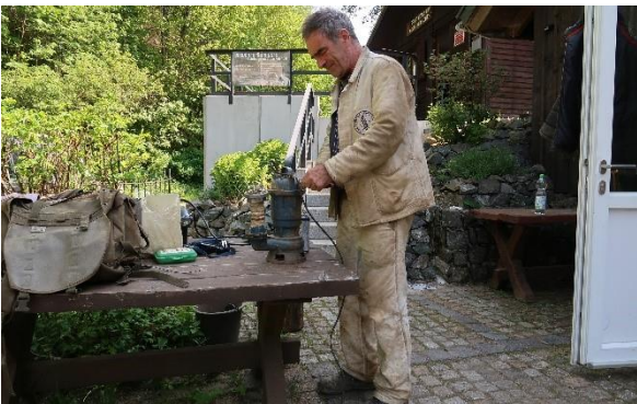
Reparatur einer Tauchpumpe
