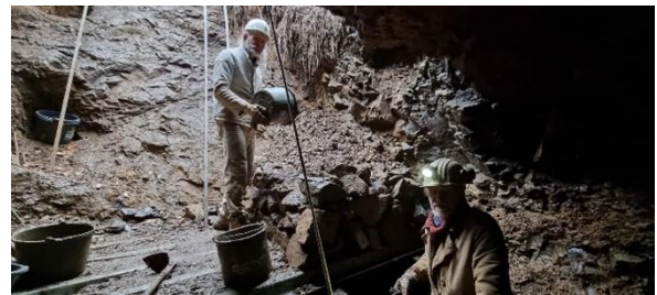
Aufbau einer neuen Schachtabdeckung im alten Schacht
