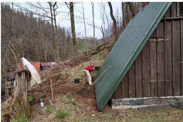
Aufräumarbeiten im Bereich des Huthauses (B. Tieben; Foto: J. Bertram, 14.04.2023)
