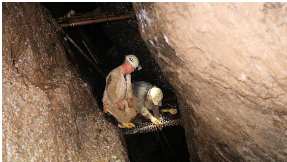
Bau und Sicherung von Bühnen (v. l.: D. Hochbaum, M. Halbas; Foto: J. Bertram, 12.05.2023)
