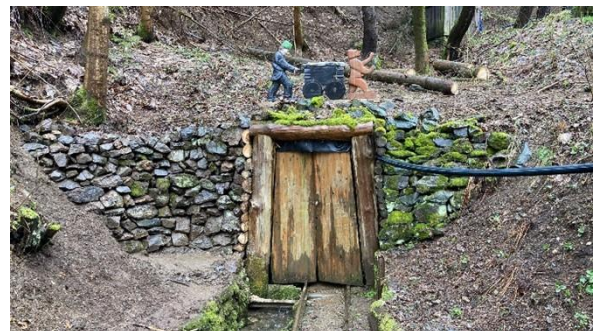
Mundloch der Grube Roter Bär nach Instandsetzung
