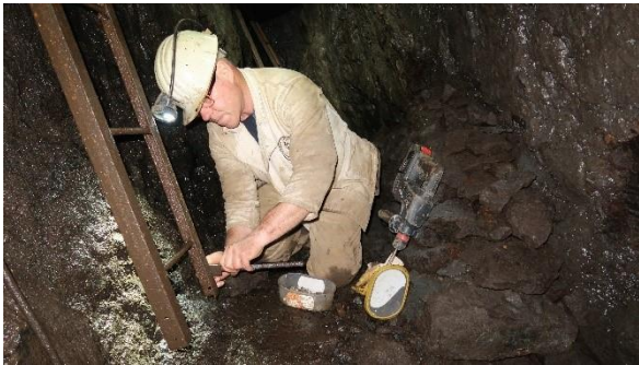
Installation von Befestigungsanker für Fahrten (D. Hochbaum; Foto: J. Bertram, 12.05.2023)
