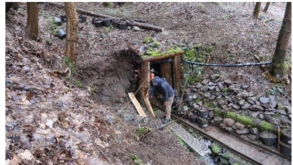
Baustellensituation kurz vor Mittag
