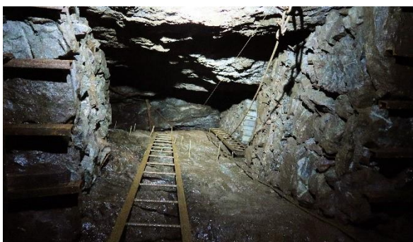
Blick in den 'Neuen Förderschacht' aus dem Niveau des St. Jacobsglücker Tagesstollens (Foto: J. Bertram, 24.06.2023)
